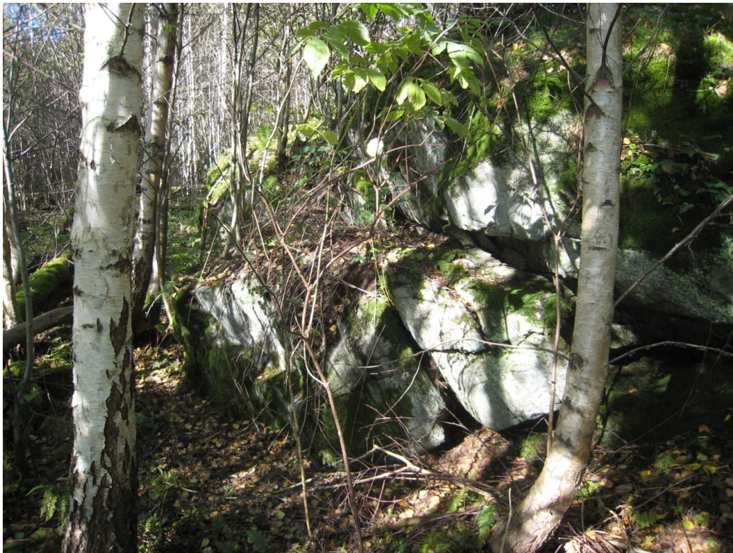
Bild 2. Område2. Uppsprucken bergslänt med utfallna lösa block.
